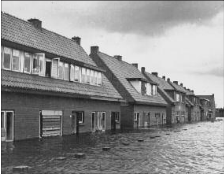
Ramen in de Wilhelminastraat in Oost-Souburg hebben het onder invloed van het water begeven en zijn met planken dichtgespijkerd | Foto 1945, ZB, Beeldbank Zeeland, recordnr. 154003.
