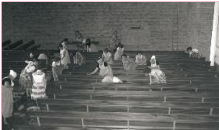
Ook de kerkbanken komen niet onder de schoonmaakkuus uit. ZB, Krantenbank Zeeland, PZC, juli 1962, recordnr. 132201.
